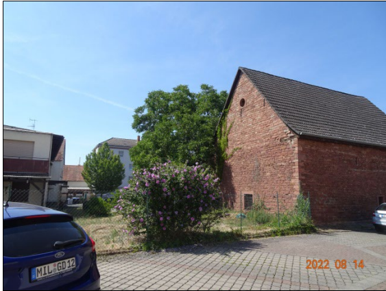
Scheune Klingenberger Straße 1
